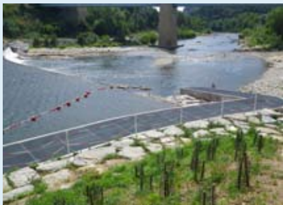
Dispositif de cheminement le long de la passe à poissons et ligne de bouées
