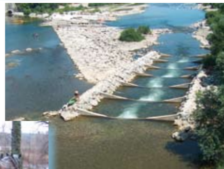
Construction d'ouvrages de franchissement piscicole
