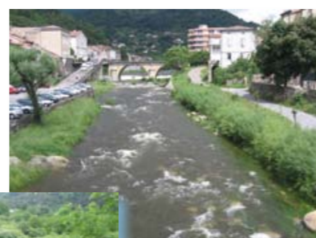
Réalisation d'ouvrages de protection de berge
