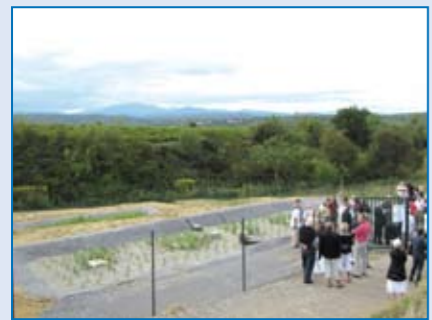
Fin des travaux et inauguration de la station d'épuration de Sauveplantade - Rochecolombe
