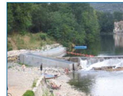
Suivi du bon fonctionnement des passes à poissons : veille sur le bon état et la sécurité des ouvrages, étude des populations de poissons.
