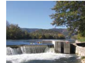
Passé à poissons terminée - seuil de Gos (septembre 2009)
