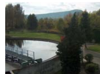
Station d'épuration grande capacité (boues activées) - Aubenas Bourdary
