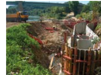
Chantier sur le seuil de Vallon-Salavas (juin 2009)
