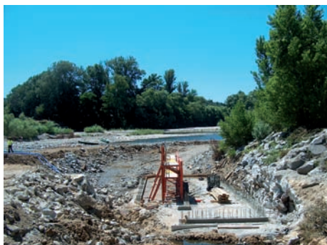
Chantier de Lanas-St Maurice d'Ardèche (le 12/06/2009)
