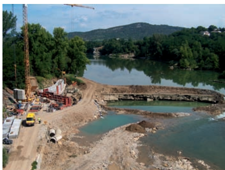
Chantier de Vallon - Salavas (le 26/06/2009)
