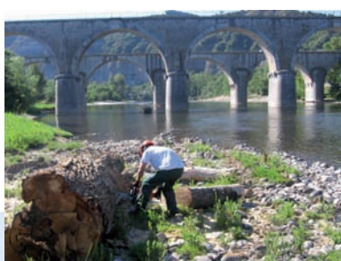
Pont de Grospière - Ruoms
