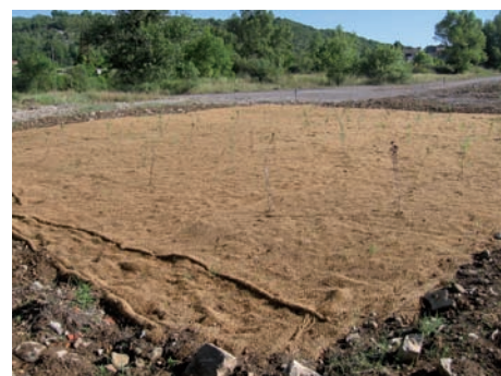
Pose d'un géotextile et plantations
