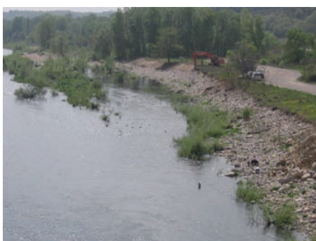
Vue d'ensemble du chantier - retalutage de la berge
