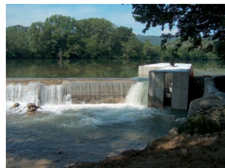
Chantier de Gos (Salavas) (le 26/06/2009)
