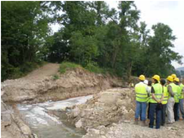
Visite des élus sur le chantier le 26/05/2009
