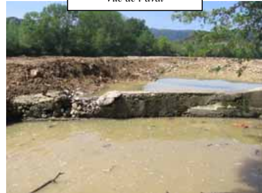
Vue de l'aval
