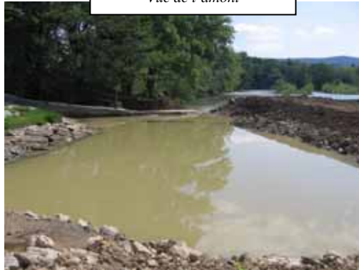
Vue de l'amont
