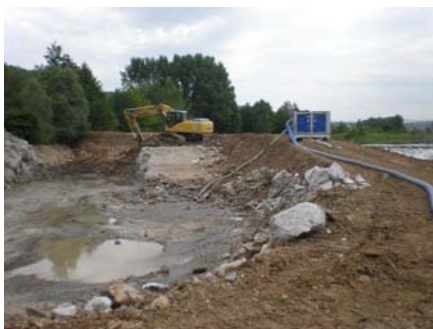
Chantier de Lanas le 26/05/2009
