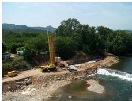
Chantier de Vallon Salavas le 25/05/2009
