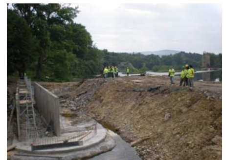
Chantier de Gos le 26/05/2009
