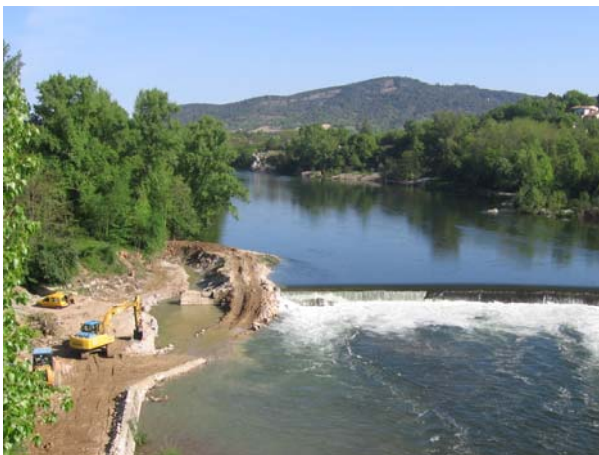
Chantier de Vallon Salavas (le 24/04/2009)
